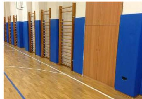
Proteção para parede interior, fabricada em espuma de polietileno reticulado, revestida do lado visível com PVC, anti-risco e lavável.
